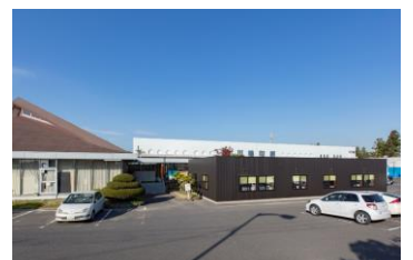
国道4号線沿いの本社工場
